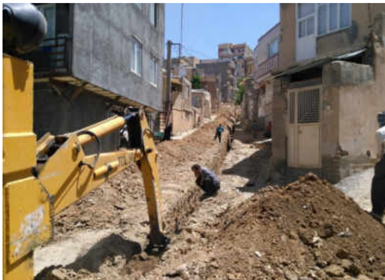
اجرای شبکه فاضلاب محله تقشقان
