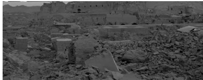
■ تصویر شماره ۷: ساختمان های بنایی
