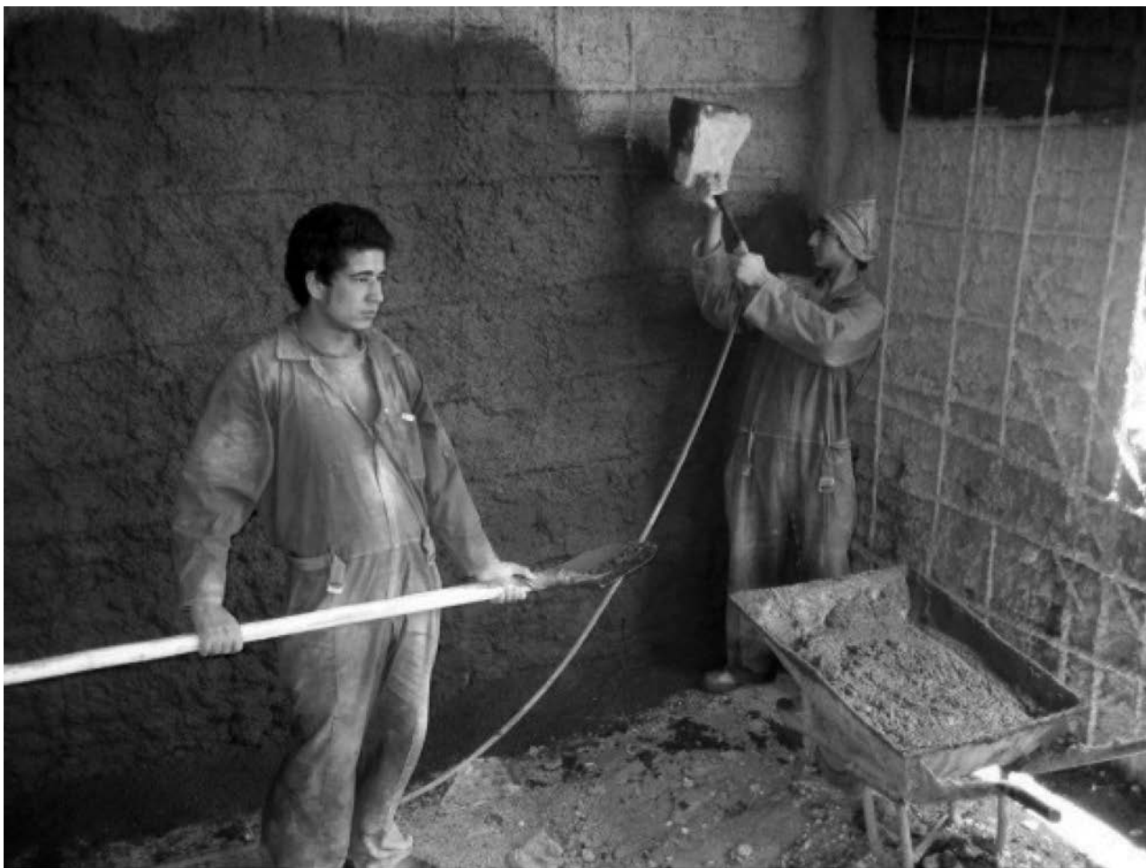
■ ساختمان های مسکونی، بدون قاب، افزودن اندود سیمانی و توری فلزی
