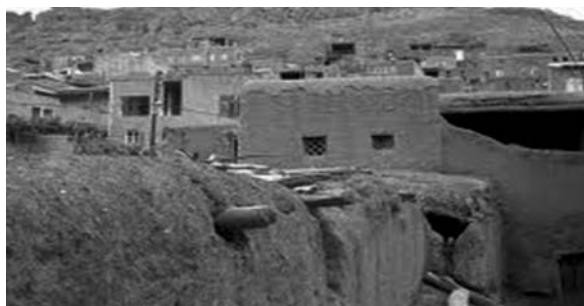
■ تصویر شماره ۹: ساختمان های بنایی
