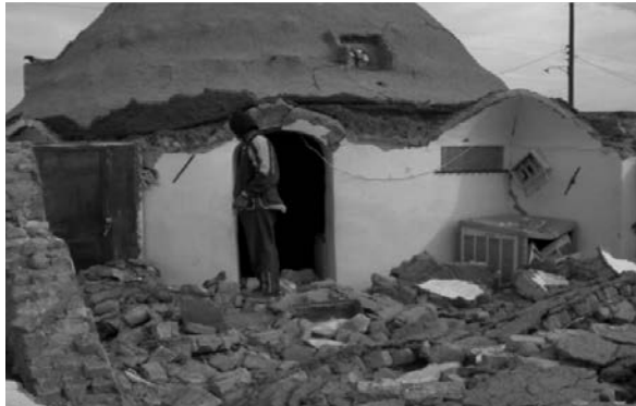
■ تصویر شماره ۸: ساختمان های بنایی
