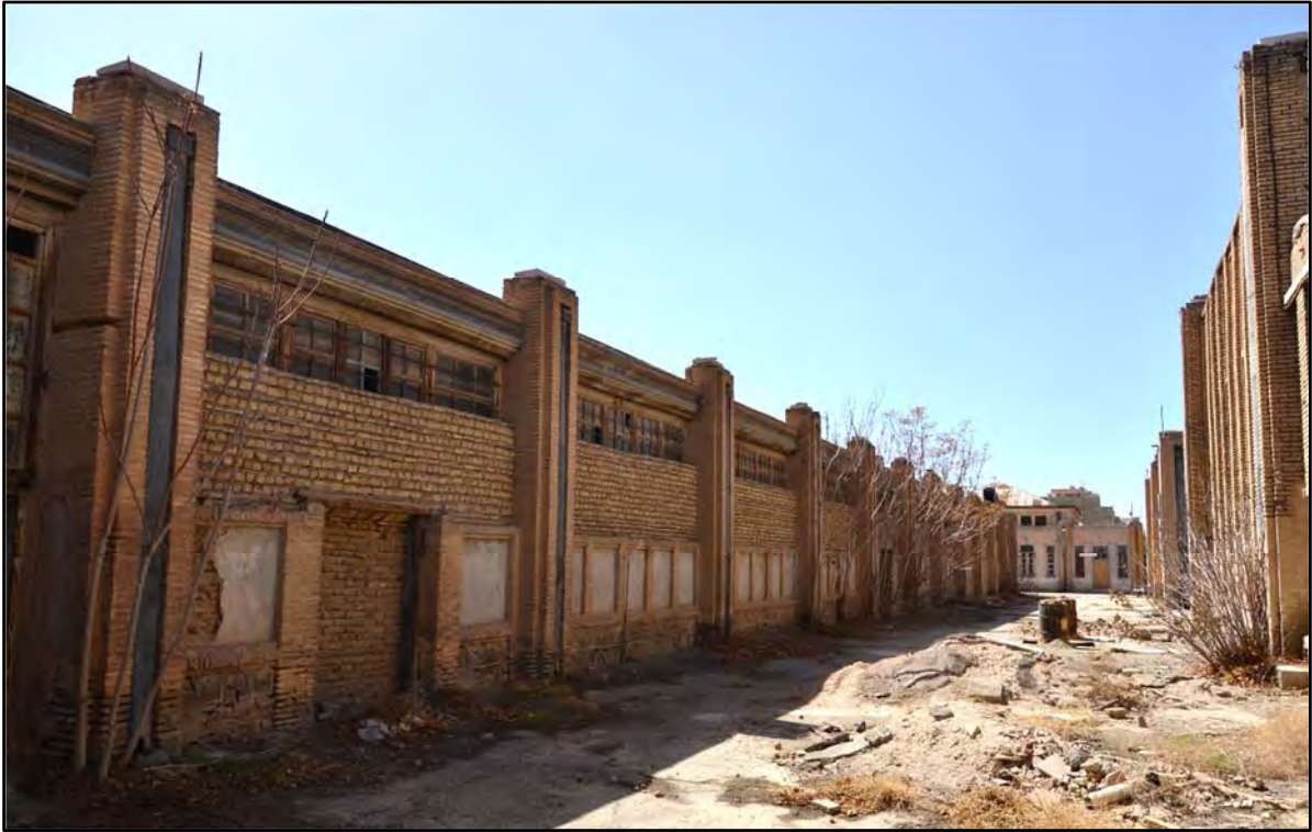
تصویر ۲۵: ردیف ستون‌های باربر سالن‌ها از بیرون؛ عکس: رضا فیضی-۱۳۹۶
