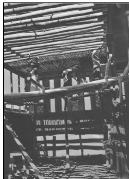
تصویر ۸: کارخانه ریسباف در حال ساخت.
