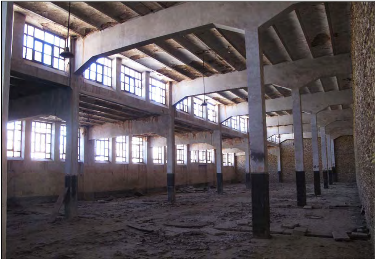
تصویر ۲۲: بخشی از سازه‌ی یکی از سالن‌های مجموعه ریسباف؛ عکس: رضا فیضی-۱۳۹۶
