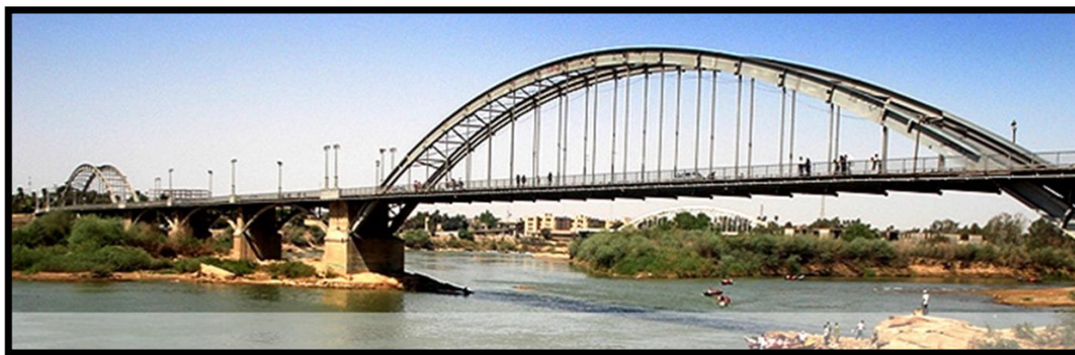
تصویر شماره ۲-۳- پل سفید اهواز
